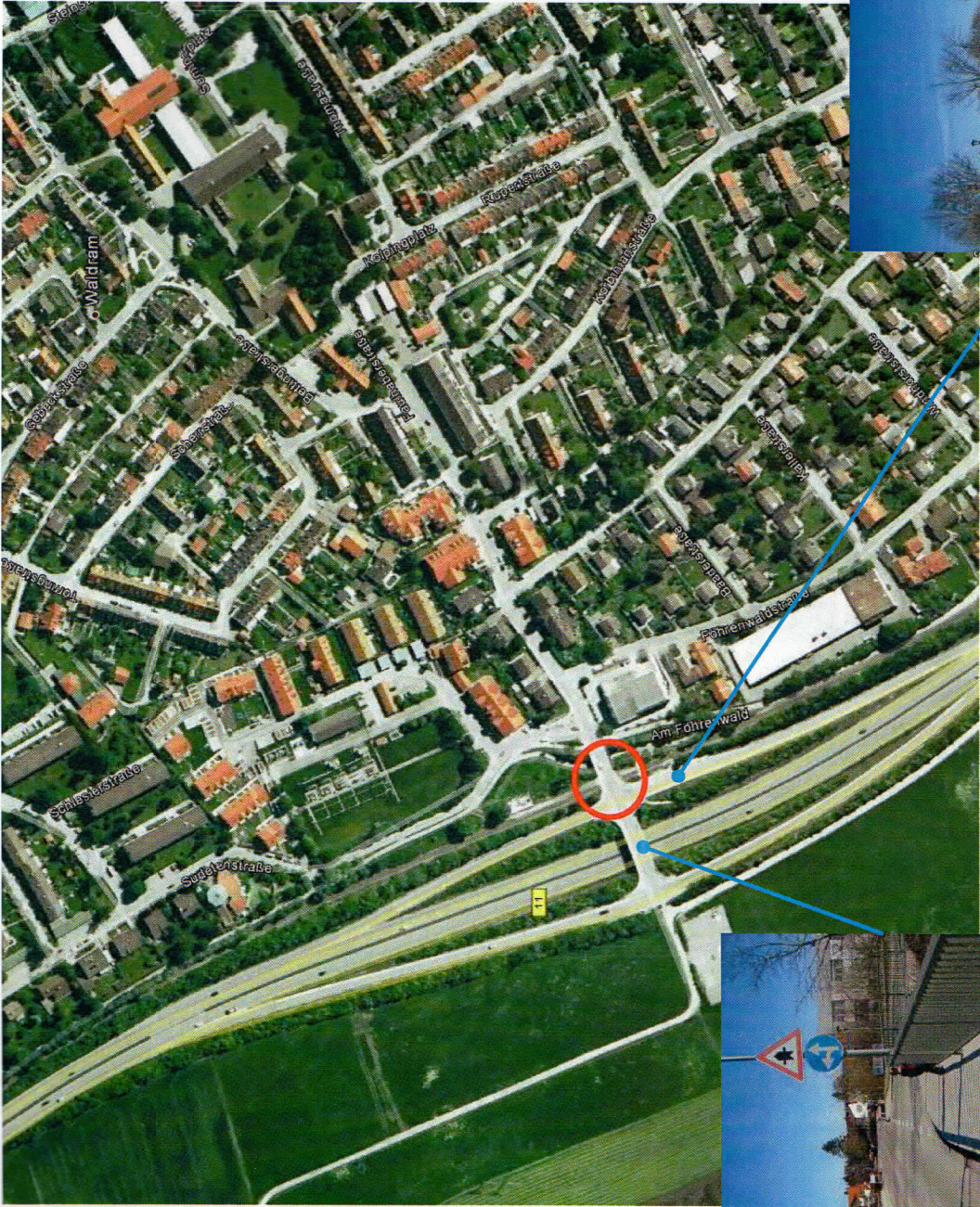
Situation höhengleicher, unbeschränkter Bahnübergang Waldram
