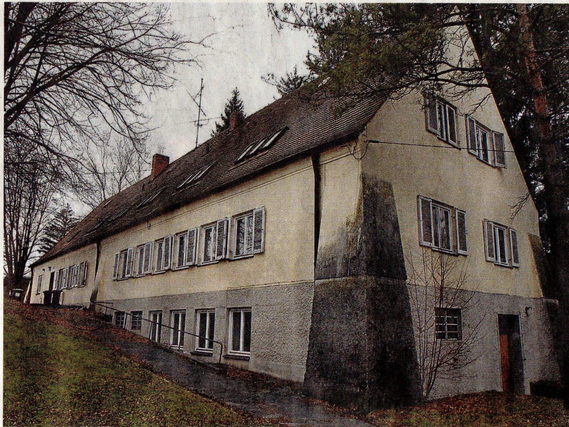
Im Erdgeschoss dieses Gebäudes am Kolpingplatz in Waldram befand sich in der Nachkriegszeit ein jüdisches Ritualbad. Links im Bild ist die Eingangstür zu sehen. Die Existenz dieser einstigen Mikwa zweifelt Bürgermeister Forster an. FOTO: SH
