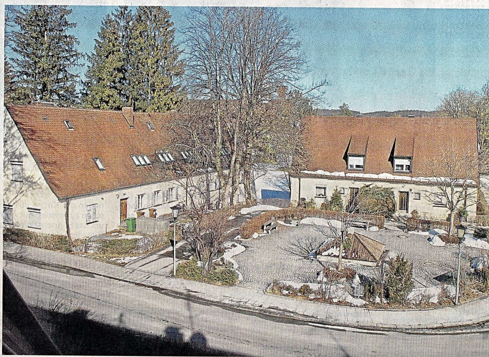
Vorbehaltlich der Zustimmung des Wolfratshäuser Stadtrates und des Diözesanrates werden die beiden Gebäude auf dem Kolpingplatz in Waldram als Ensemble erhalten.
