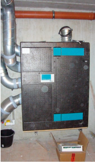
Lüftungsanlagen mit Wärmerückgewinnung auch für kleinere Eigenheime sorgen nach einer Sanierung für den hygienischen Mindestluftwechsel und können die Radonkonzentration senken
